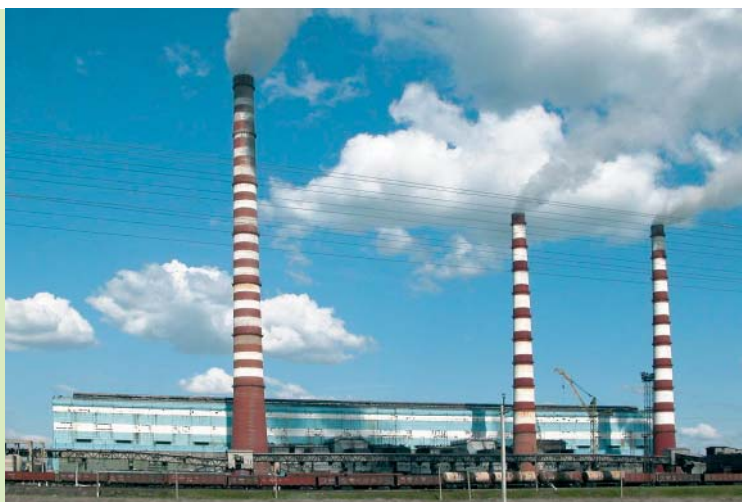
Рис. 1. Общий вид станции
