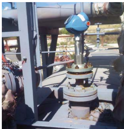
Рис. 2. Rosemount 5300 установлен взамен отказавшего буйкового уровнемера на ёмкости со сжиженным аммиаком
