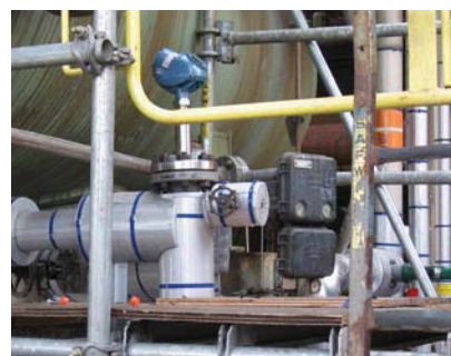
Рис. 3. Rosemount 5300 установлен на сепараторе. Измеряет уровень границы раздела вода/дизельное топливо
