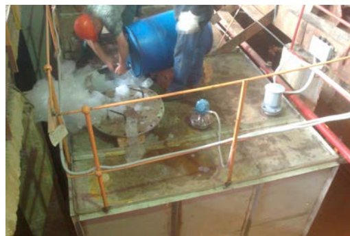
Измерение уровня пенообразователя с помощью уровнемера 5401 с рабочей частотой 6 ГГц.
