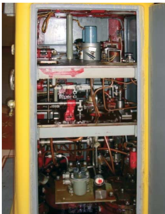
▲ Рис. 3, 4. Колонка управления поворотно-лопастной турбины до реконструкции (слева) и после реконструкции с электроприводом прямого управления главными золотниками НА и РК (справа), Нарвская ГЭС
