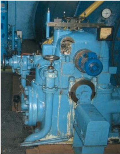
▲ Рис. 5, 6. Система регулирования гидроагрегата № 3 Кондопожской ГЭС до модернизации (слева) и после модернизации (справа)
