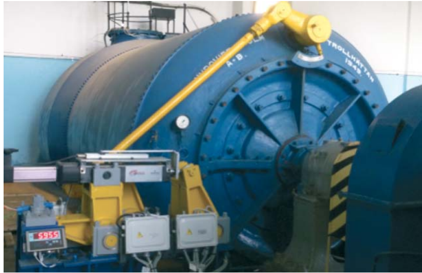
▲ Рис. 5, 6. Система регулирования гидроагрегата № 3 Кондопожской ГЭС до модернизации (слева) и после модернизации (справа)
