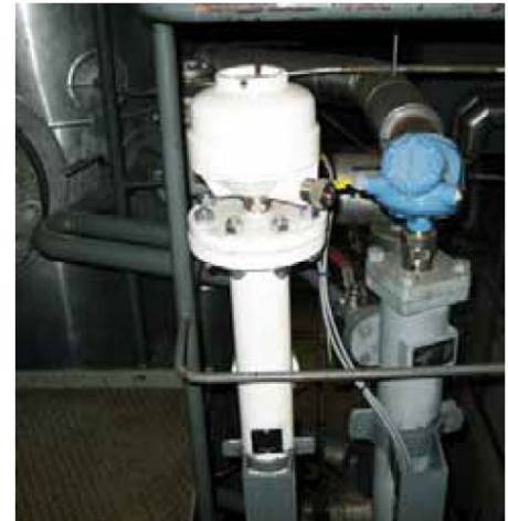
图 1. 罗斯蒙特 5301 取代冷凝器液位控制测量室上的位移式开关。
