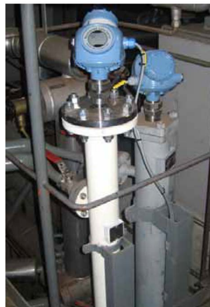
图 2. 第二个罗斯蒙特 5301 取代电子位移式开关。
