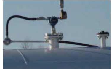
图 1. 已安装的罗斯蒙特智能无线 THUM 适配器
