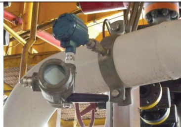
非侵入罗斯蒙特管夹式 RTD 传感器测量自流管道的管道表面温度。
