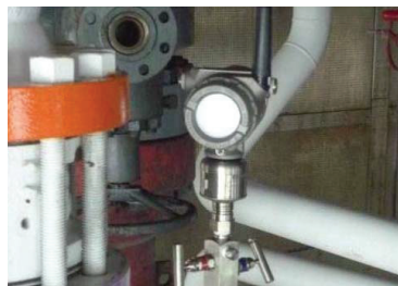
罗斯蒙特无线压力变送器 3051S，用于无线测量自流管道压力。
