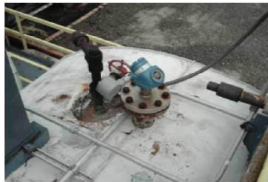
图 2：罗斯蒙特 5302 导波雷达能够可靠地测量脱盐装置容器上的乳剂层。
