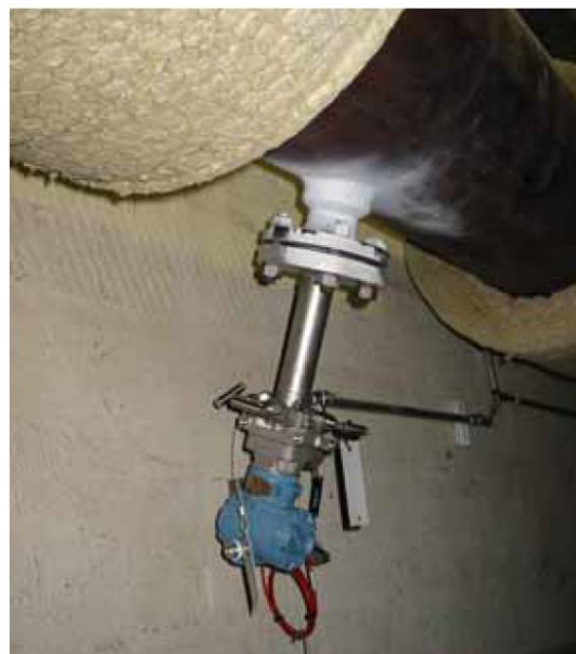
图 1. 罗斯蒙特阿牛巴流量计的安装
