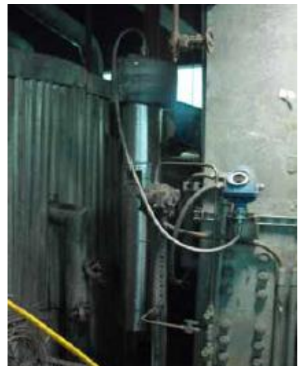
그림 1: 로즈마운트 5301와 동적 증기 보상기능은 보일러 드럼에 대해 믿을 수 있는 측정값을 제공한다.
