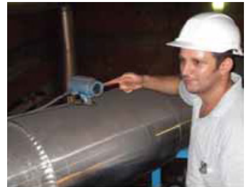
Rosemount 8800D Vortex monitoimilähetin apukattilalta tulevassa kylläisen höyryn linjassa
