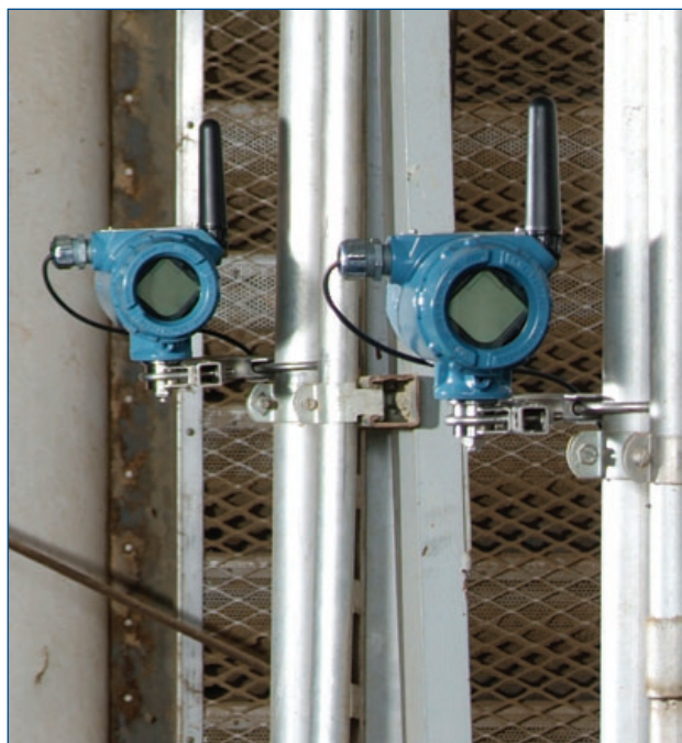
Prístroj CSI 9420 je jednoduchým doplnením ktorejkoľvek existujúcej bezdrôtovej komunikačnej siete.
