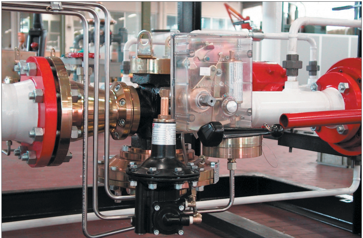
Fragment linii redukcyjnej z CB - SRS. Przepływ gazu od strony prawej do lewej.
