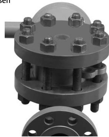
Abbildung 12. Installation bei Fisher 249W abgeschlossen
