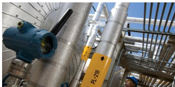
Strumento di misura di temperatura Rosemount Wireless
