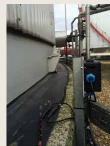
Trasmettitore discreto wireless 702 Rosemount di Emerson
