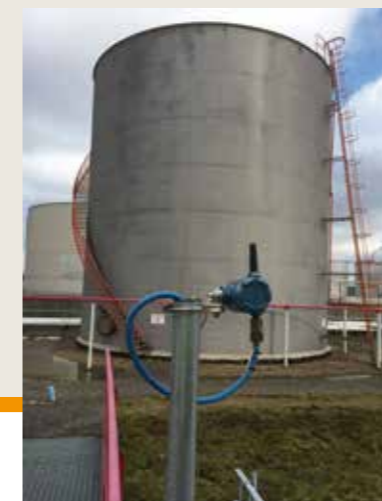
La tecnologia Smart Wireless di Emerson ha eliminato la necessità del cablaggio di nuova strumentazione e dei relativi scavi e condotti
