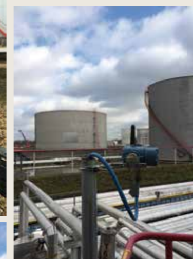
La tecnologia Smart Wireless di Emerson ha eliminato la necessità del cablaggio di nuova strumentazione e dei relativi scavi e condotti
