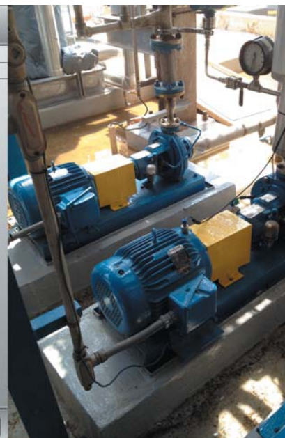
РИС. 4. ▼ Беспроводной датчик вибрации, установленный на насосе, обеспечивает ценными данными автоматизированную систему контроля
