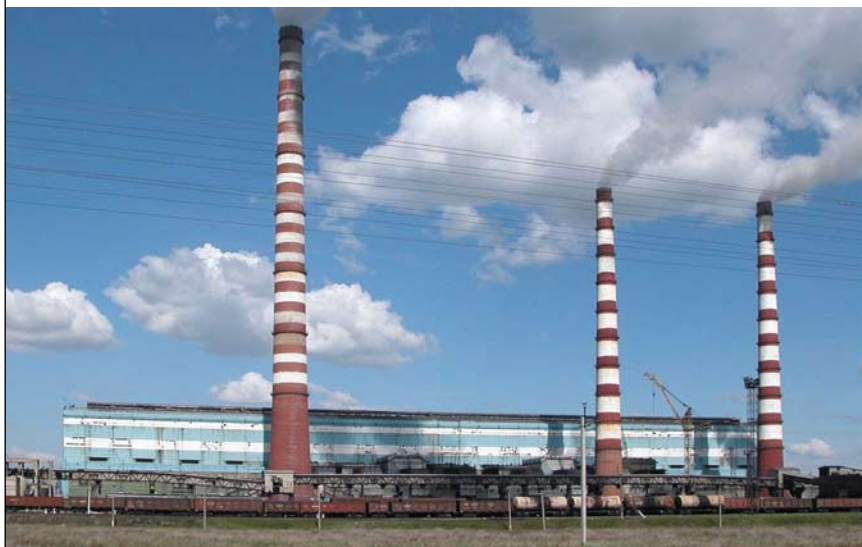
На фото: Общий вид станции
