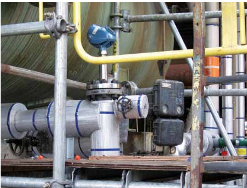
Рис.2. Rosemount 5300 установлен на сепараторе. Измеряет уровень границы раздела вода/дизельное топливо
