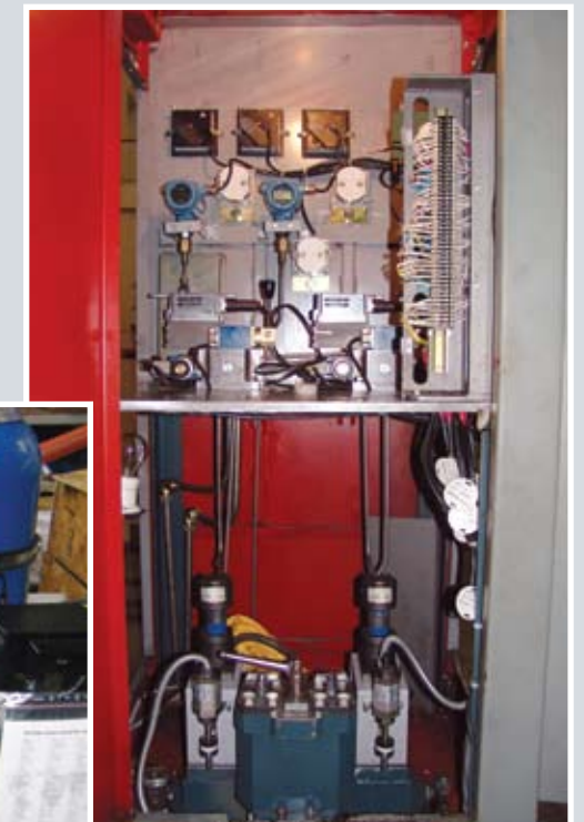
Рис. 1. Модернизация гидромеханической части регулятора скорости на базе ЭГУ и МНУ ВД
