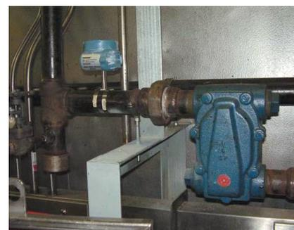
*В конструкцию беспроводного акустического преобразователя 708 Rosemount входят встроенные датчики, устанавливаемые снаружи контролируемого оборудования, что упрощает и снижает стоимость процесса монтажа и исключает вмешательство в технологический процесс.*
