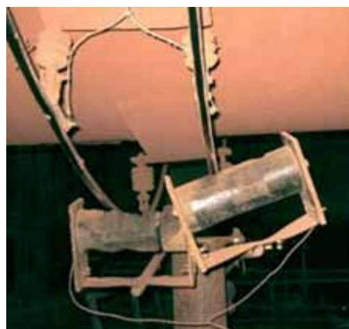
Рис. 1. Измерения на вращающейся трубной печи с токосъемными устройствами.
