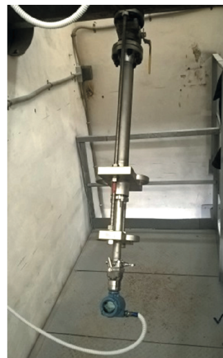
Расходомер Метран 350SFA с механизмом Flo-Tar для извлечения без остановки технологического процесса
