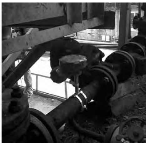
Рис. 1. Преобразователь Rosemount 708 на конденсатоотводчике
