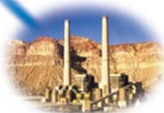
石炭火力発電所
