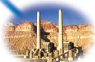
石炭火力発電所
