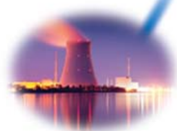
原子力発電所
