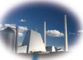
バイオマス発電所
