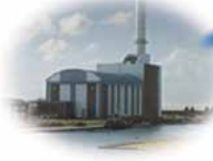
Парогазовая установка или установка с одной турбиной
