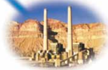
Электростанция, работающая на угле
