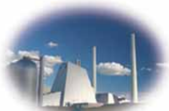
Электростанция на биомассе
