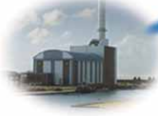
Парогазовая установка или установка с одной турбиной
