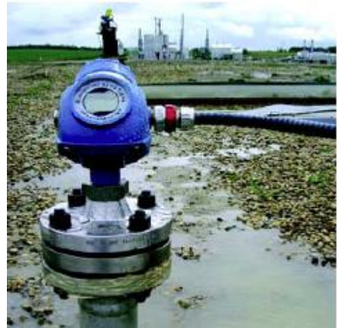
로즈마운트 5400은 정수정 Shell에 장착되었다. 안테나는 내부 파이프에 맞도록 다듬어졌다.
