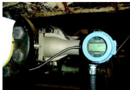
WE Energies의 로즈마운트 8800 MultiVariable 증기 장치
