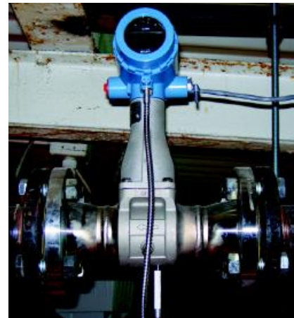
로즈마운트 8800 MultiVariable™ 스팀 라인 설치
