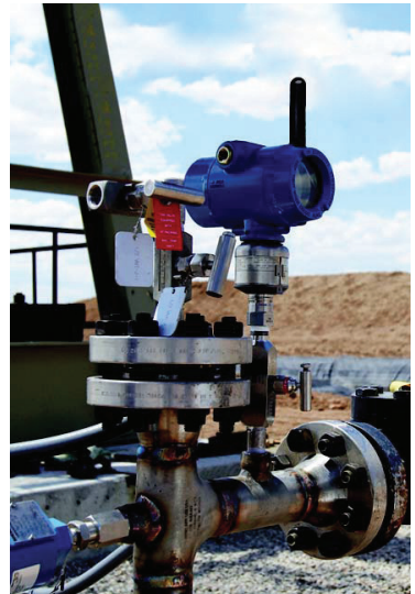
已安装的罗斯蒙特无线压力变送器 3051S
