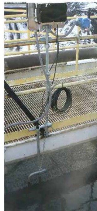
Mobrey 灰浆层料位监测器 MSL600 和罗斯蒙特无线温度变送器 648
