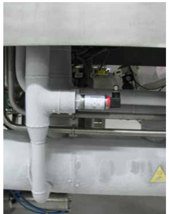
图1. 安装的罗斯蒙特紧凑型无线音叉液位开关2110
