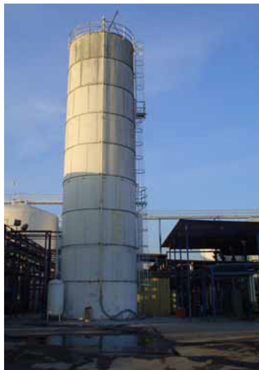
图1：硅藻土作为酒过滤剂，存放在这个80英尺高的料仓中。
