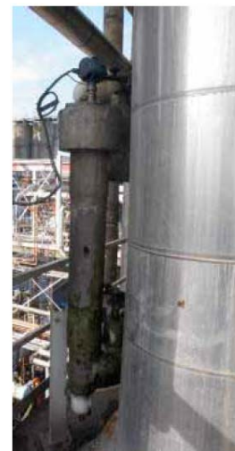
图 1. 带有诊断套件的罗斯蒙特 5301 用于监测不正常的过程条件。
