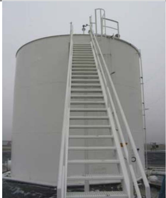
柔性电缆是这个 24 英尺 (7.3 米) 储油罐的唯一选择
