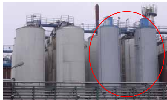
图中前方右侧为生石灰储料仓，用于净化生产中所用的水。
