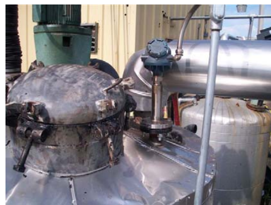
図 1 : Rosemount 5301 取り付け図
