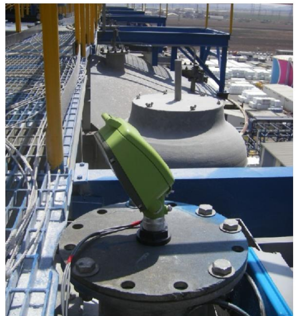
安装在料仓内的三维成像物位仪
