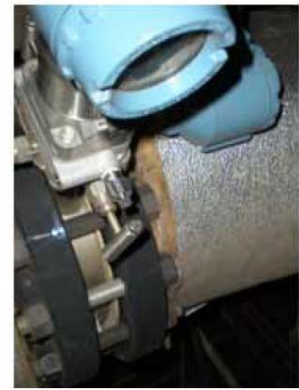
图 2: 紧凑型阿牛巴流量计安装在两个凸面法兰之间。
