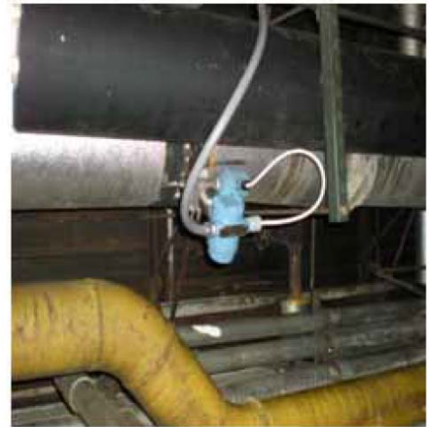
图 1. 罗斯蒙特 3051SFC 紧凑型阿牛巴流量计的安装
