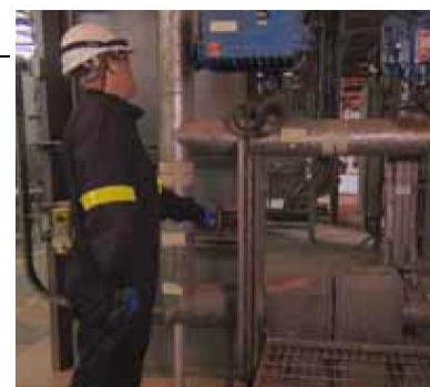
以前需通过手动检查监测蒸汽疏水阀。这不仅耗费时间，还无法指出泄漏的发生时间或原因。
