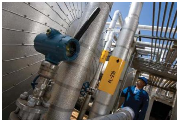
Trasmettitore installato nei depositi di BP
