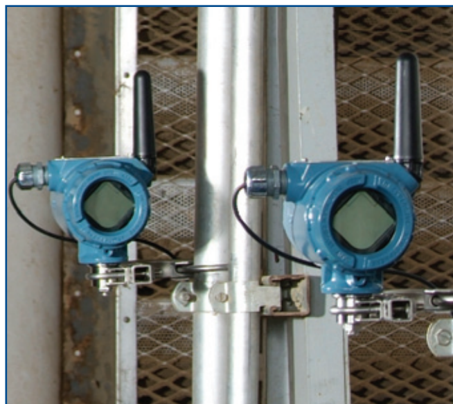
Przetwornik CSI 9420 łatwo dodać do istniejącej sieci bezprzewodowej.
