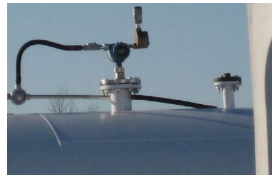
Adaptador inalámbrico inteligente THUM de Rosemount instalado.
