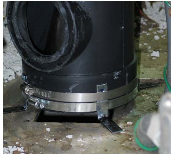
Rosemount 5401 が既存のタンクの開口部に試験的に取り付けられました。
