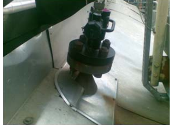
采用罗斯蒙特应用与行业解决方案 (AIS) 蓝宝石温度传感器的克劳斯回收设备
