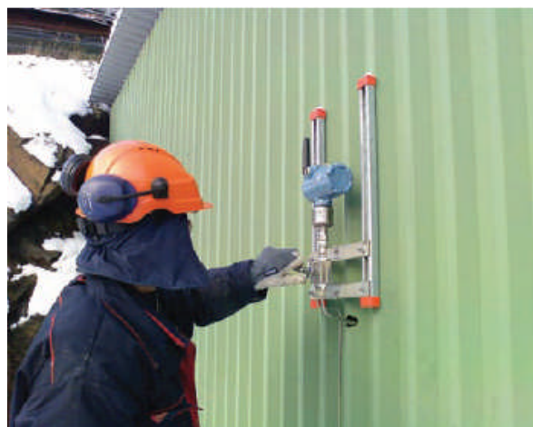
Il trasmettitore di pressione Rosemount® fornisce la misura della pressione dei serbatoi sotterranei
