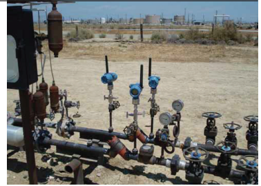
蒸汽复式注入井上的 WirelessHART 压力变送器 3051S。
