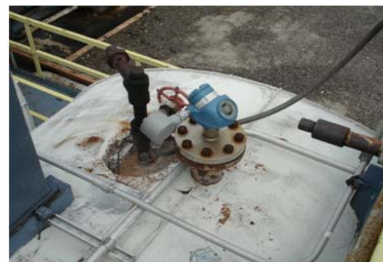
Figura 2. Rosemount 5302 Radar de Onda Guiada Mide de manera fiable la capa de emulsión en los tanques desalinizadores.
