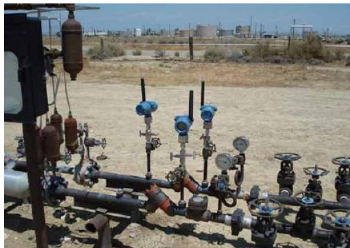
Trasmettitore di pressione 3051S WirelessHART pressure transmitters su un pozzo a doppia linea.
