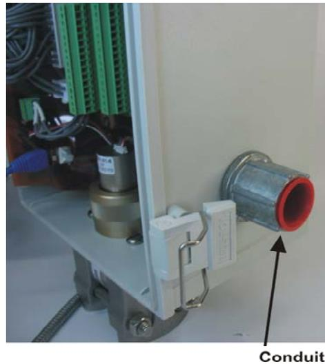
*Figure 4. Conduit for Wiring*
